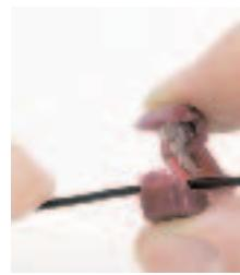
Colocar los cables en el conector
