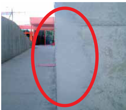
Esquina reparada con Risan R.
